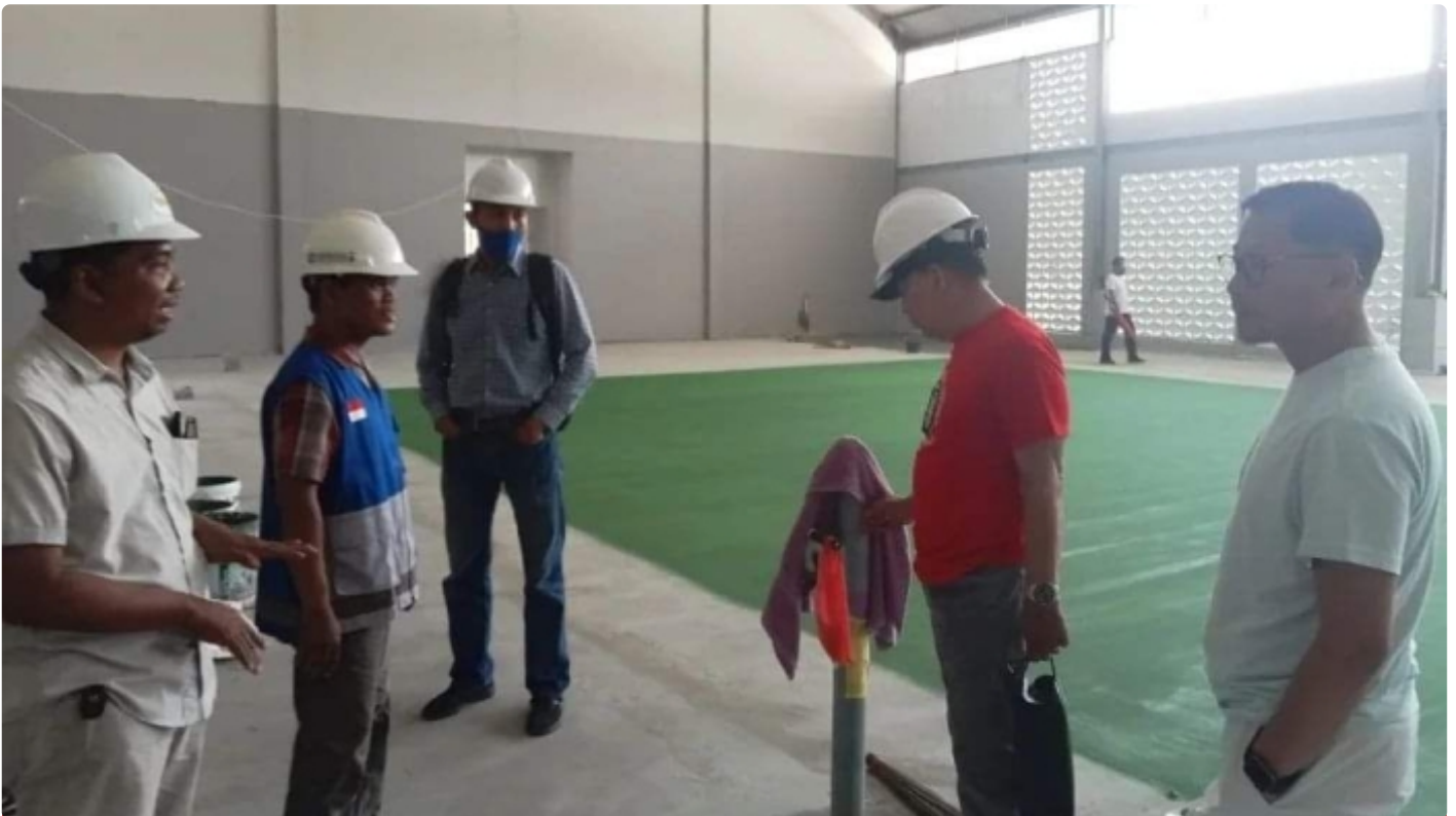
Kakanwil Kemenkumham Jateng Tinjau Pembangunan Lapangan Tenis Indoor / Foto : Humas Kanwil
